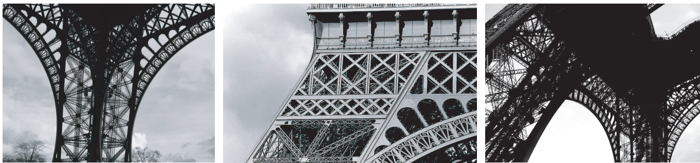
FIG. 2 – Quelques détails de la structure de la tour Eiffel
